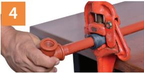
Prevea la limpieza de las roscas y compruebe en seco el roscado del tubo con el accesorio a instalar.
