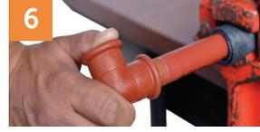
Efectuar el ajuste mediante presión manual del tubo con el accesorio.
