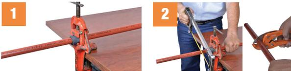
Colocar el tubo en un tornillo de banco o mordaza sin exagerar el ajuste para una lija. Se recomienda evitar ovalamientos, pues esto provocaría una rosca para realizar cortes a imperfecta. Proteger el tubo de PP con un tramo de Polietileno y/u otro medio.
