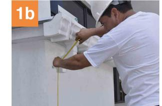
Si los canales están a una distancia determinada del muro o pared (sistema colgante), se instalará un codo de bajante de 45° con el respectivo soporte sobre el muro y otro desde la unión de canal a bajante conectados entre sí por un tramo de bajante.
