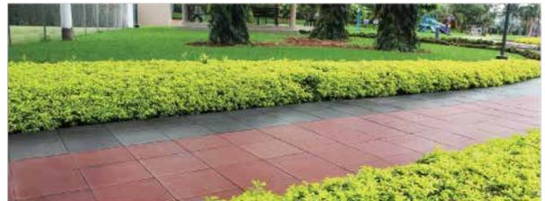
**Resistentes al alto tráfico:** Su cocción a altas temperaturas le confiere dureza y alta resistencia al desgaste.
