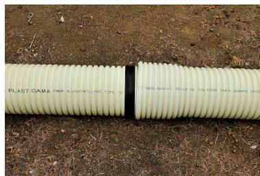
Coloque el caucho en dos valles consecutivos del extremo del tubo hasta 440mm de diámetro, en correspondencia con la parte lisa de la campana, a partir de 540 el anillo de caucho se alojará a partir del primer valle, asegúrese que quede firmemente asentado.
