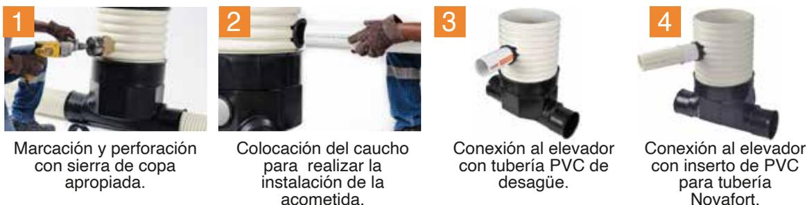
Previo a la operación del sistema realice pruebas de estanqueidad, según corresponda, para garantizar una correcta instalación. Para pedidos especiales se puede trabajar con elevadores de 400mm. Consultar con el Departamento Técnico de Plastigama.
