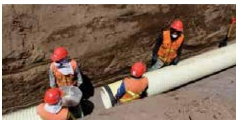
NOVAFORT PLUS es una tubería liviana que se puede manejar fácilmente en obra por cuadrillas pequeñas y hace innecesario el uso de equipo pesado en su manejo e instalación.
