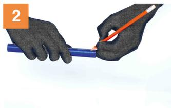
Asegúrese de marcar la inserción del tubo para evitar su introducción excesiva y causar obstrucción en la unión. Luego limpiar con alcohol industrial tanto tubos como accesorios para evitar impurezas y realizar una correcta termofusión.
