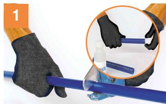
Corte el tubo TERMOMAX, en ángulo recto, de preferencia utilizando la tijera cortatubo.
