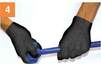
Inserte el tubo en el accesorio, hasta la marca tope respetando el tiempo de trabajo (T2) indicado en la tabla No.3, "Condiciones para termofusión". Finalmente cumplir con el tiempo de enfriamiento (T3) luego del ensamble.
